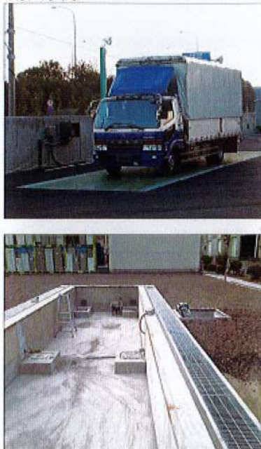
基礎工事の様子
